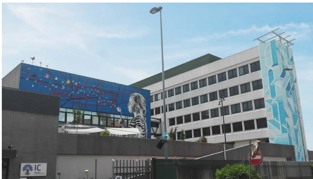
La facciata del Data Center di InfoCamere a Padova
