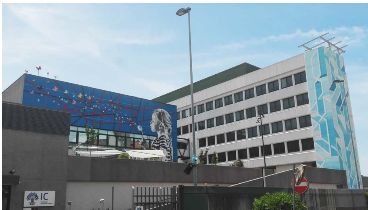
La facciata del Data Center di InfoCamere a Padova A destra l'opera di Joys, a sinistra quella realizzata lo scorso anno da Zeromentale e Alessio-B.
